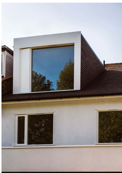
Revêtement en tuiles pour les joues des lucarnes
