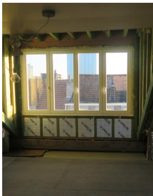
Vue de la lucarne (manque finition intérieure et châssis). Situation de fait
